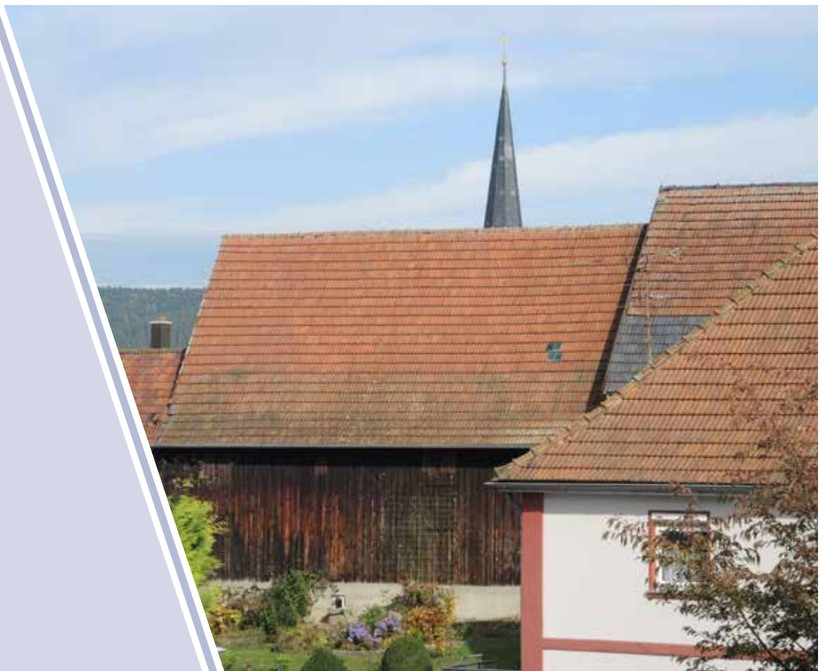
Dachlandschaft - Haupt- und Nebengebäude
