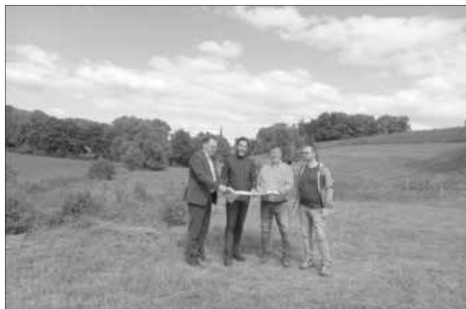
Baustart am Pumpwerk in Schmölz: Das Bild zeigt (von links) Verbandsvorsitzenden Bernd Rebhan, Markus Möckel (Büro SRP), Bauleiter Stefan Becker (Fa. Krumpholz,) und Michael Stadler (Bauamt Markt Küps).
