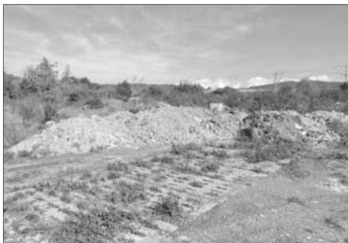
Die Fläche im Jahr 2022 vor Beginn der Sanierungsmaßnahme.
